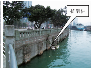
图11 万州和平广场滑坡悬臂抗滑桩
